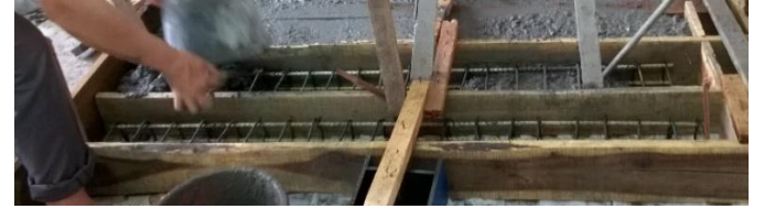
b) Pouring ready-mix concrete
