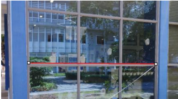
(a) Cạnh 11 đo bằng thước kẻ có chiều dài 3,35 m.
