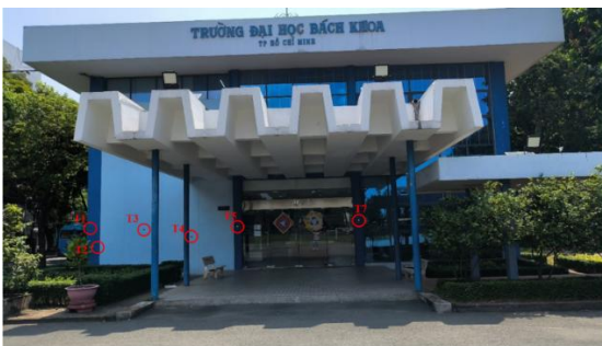
Hình 5. Hình ảnh minh họa vị trí một số GCPs được đánh dấu trên bề mặt công trình (bên trong vòng tròn đỏ).
