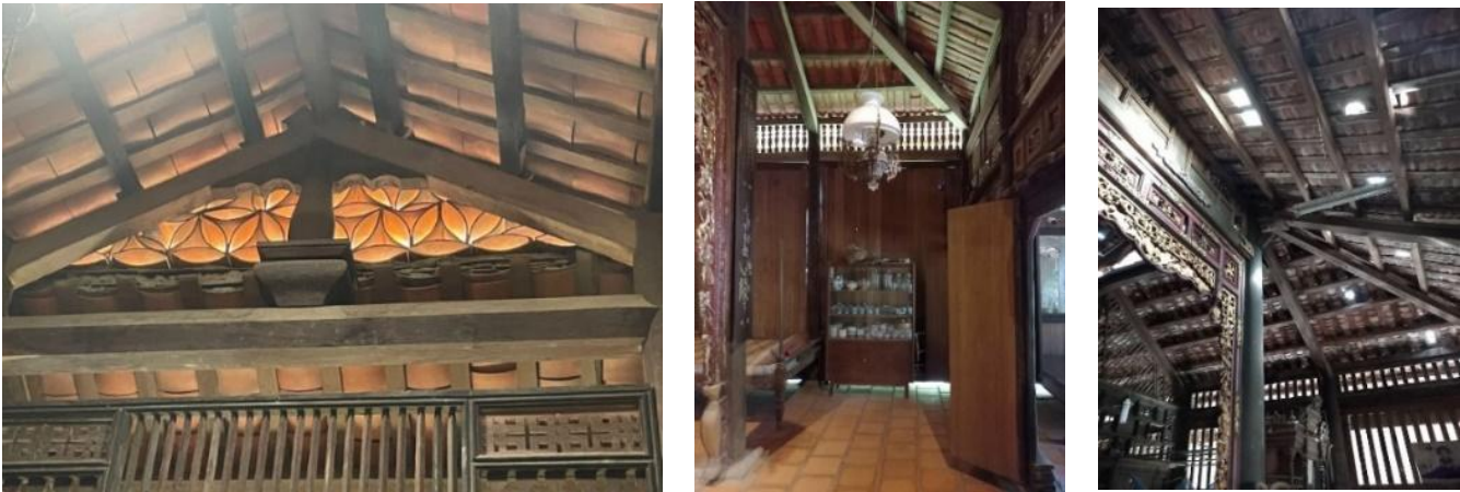
Hình 5. Giải pháp chiếu sáng tự nhiên với mái chữ A và tường nan trong ngôi nhà của ông Kiệt.
