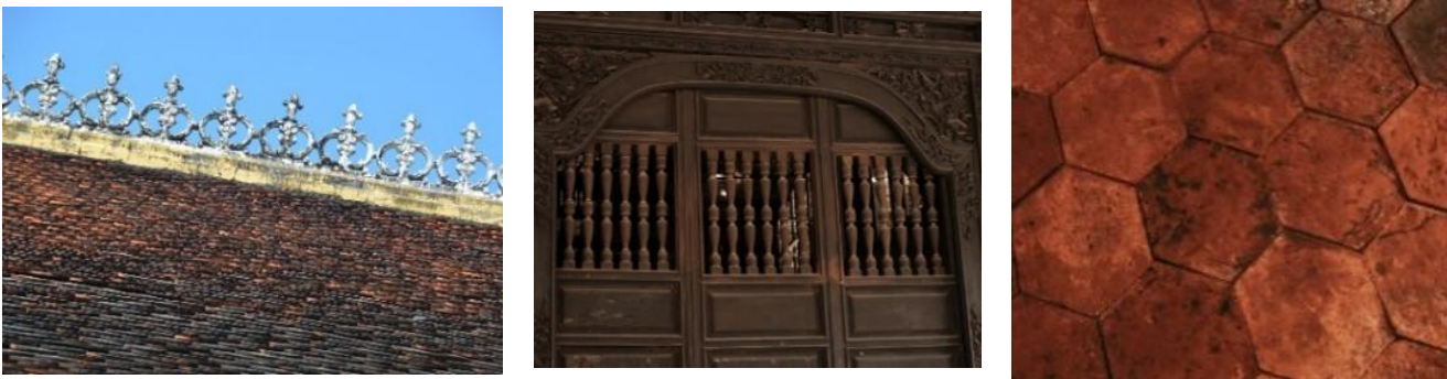
Hình 6. Giải pháp hạn chế sự truyền nhiệt sử dụng vật liệu ngói, gỗ và gạch trong ngôi nhà của ông Ba Đức.
