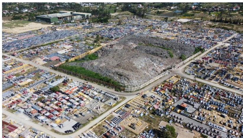
Hình 11. Ảnh bãi chôn lấp theo hiện trạng.
