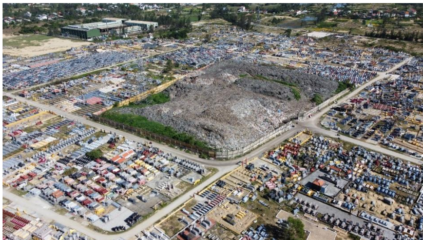
Hình 11. Ảnh bãi chôn lấp theo hiện trạng.
