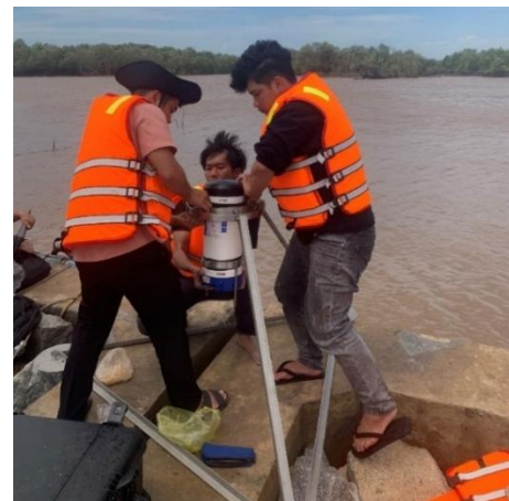
Hình 3. Lắp đặt thiết bị đo sóng ADCP Sentinel-V20.
