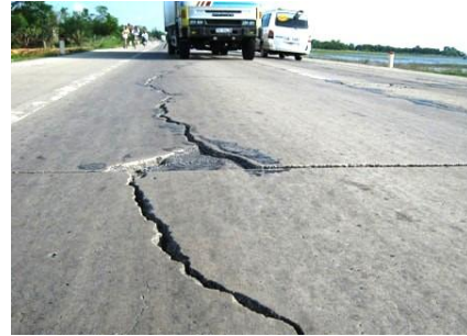
Hình 1. Hư hỏng mặt đường bê tông.
