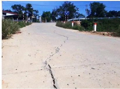
Hình 1. Hư hỏng mặt đường bê tông.
