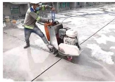
Hình 2. Thiết bị sửa chữa mặt đường bê tông.
