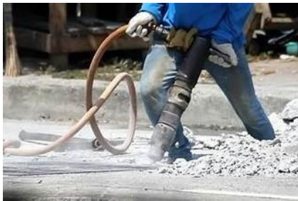
Hình 2. Thiết bị sửa chữa mặt đường bê tông.
