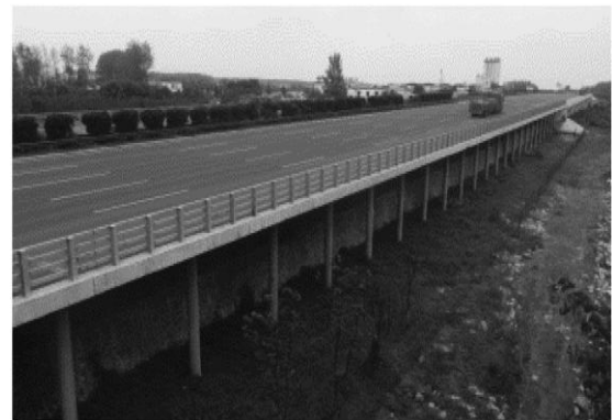
Hình 1. Ứng dụng kết cấu sàn cọc.
