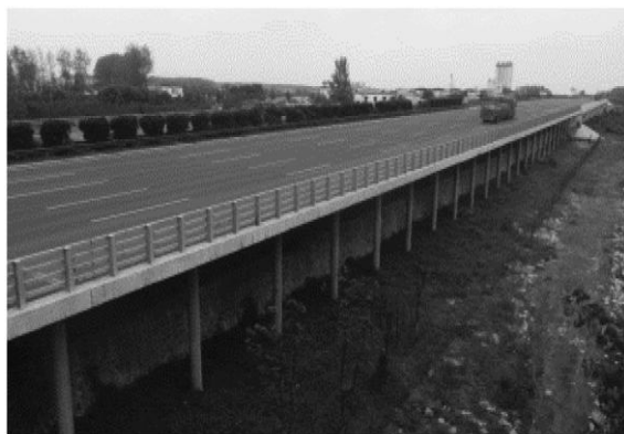
Hình 1. Ứng dụng kết cấu sàn cọc.
