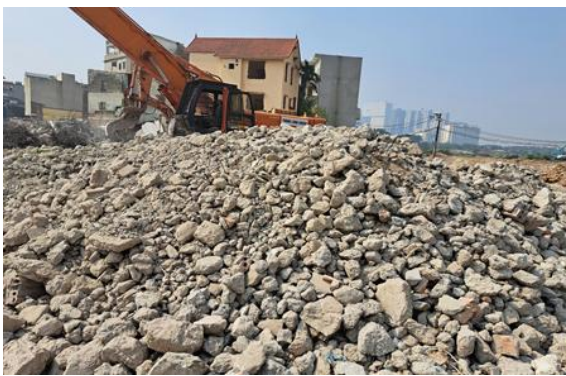
a. Cốt liệu bê tông tái chế ngay sau khi được phá từ công trình xây dựng b. Cốt liệu được sàng phân thành các loại đường kính cỡ hạt
