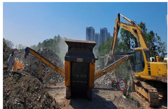
a. Cốt liệu bê tông tái chế ngay sau khi được phá từ công trình xây dựng b. Cốt liệu được sàng phân thành các loại đường kính cỡ hạt
