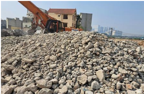
a. Cốt liệu bê tông tái chế ngay sau khi được phá từ công trình xây dựng
