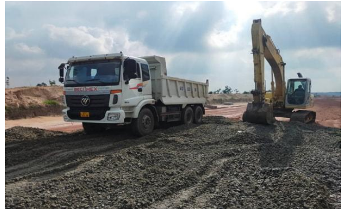
Hình 4. Thi công nền đường bằng đất đắp tại tỉnh Tây Ninh.
