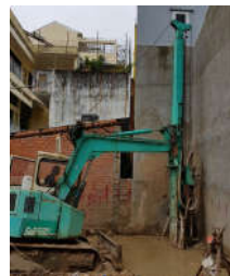
Hình 1.a: Thi công cọc khoan nhồi đường kính nhỏ làm cọc chịu lực
