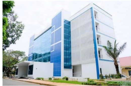
(a) Tòa nhà giảng đường đa năng
