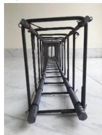
c) Hình ảnh cốt thép dầm sau khi lắp đặt
