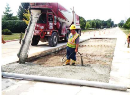
(b) Thi công sử dụng vật liệu xi nơ làm vật liệu IC mặt đường BTXM tại Ấn Độ [26]
