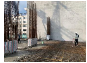
Kiểm soát cao độ đổ bê tông sàn
