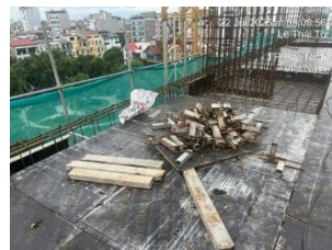
Lắp dựng cốt thép lớp dưới mũ cột
