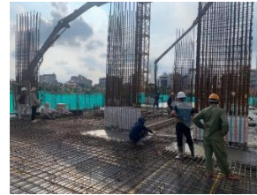
Đổ bê tông mũ cột
