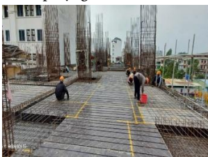
Lắp dựng thép sàn lớp dưới
