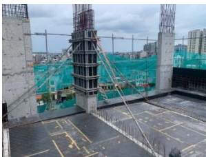
Lắp dựng ván khuôn sàn
