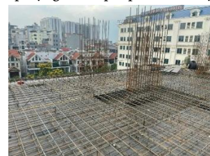
Lắp dựng thép sàn và mũ cột lớp trên
