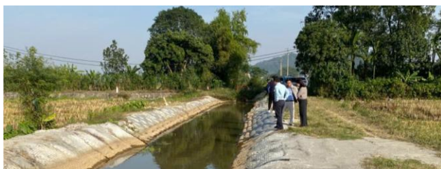
Hình 10. Thảm địa kỹ thuật làm đầy vữa bê tông hoàn thành thực nghiệm (khai thác và sử dụng).
