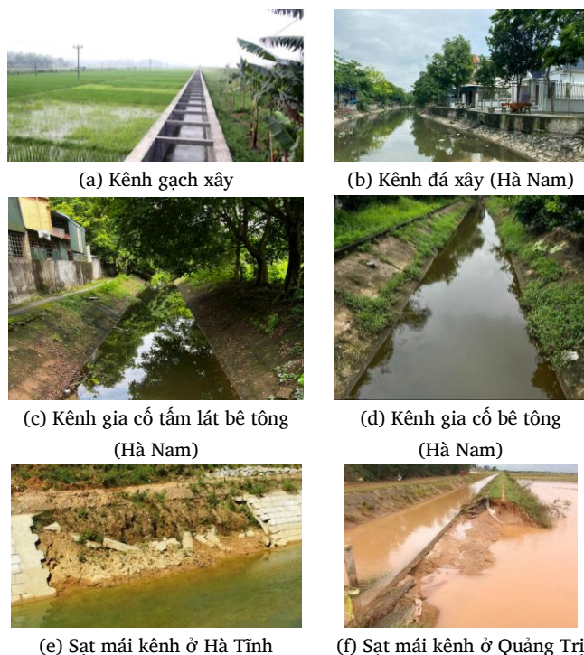
Hình 1. Một số giải pháp gia cố mái kênh mương phổ biến ở Việt Nam [2, 3].
