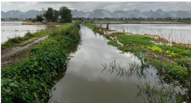
Hình 4. Hình ảnh khảo sát thực địa hiện trường đoạn kênh mương trước khi gia cố mái (2024) [7].
