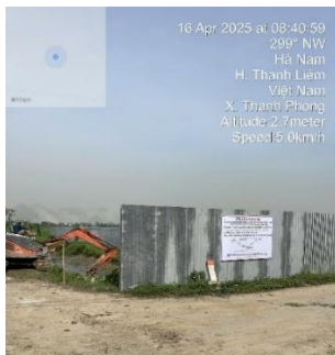
a) Chuẩn bị công trường
