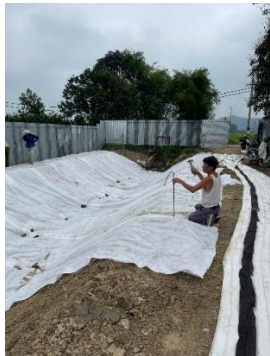
a) Thi công trải vải địa
