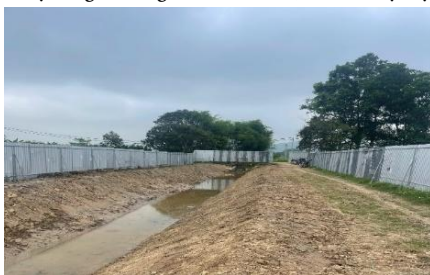
c) Hoàn thiện mặt bằng thi công gia cố mái kênh
