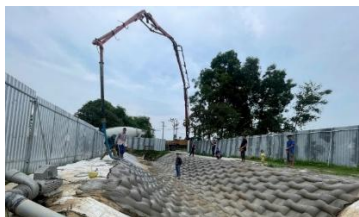
d) Thi công bơm bê tông vào thảm địa
