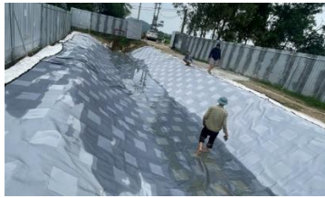
b) Thi công trải thảm địa kỹ thuật hai lớp
