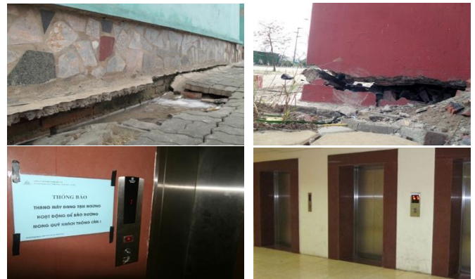
Hình 3. Hệ thống đường ống cấp nước và điện bị hư hỏng tại các khu chung cư tái định cư.
