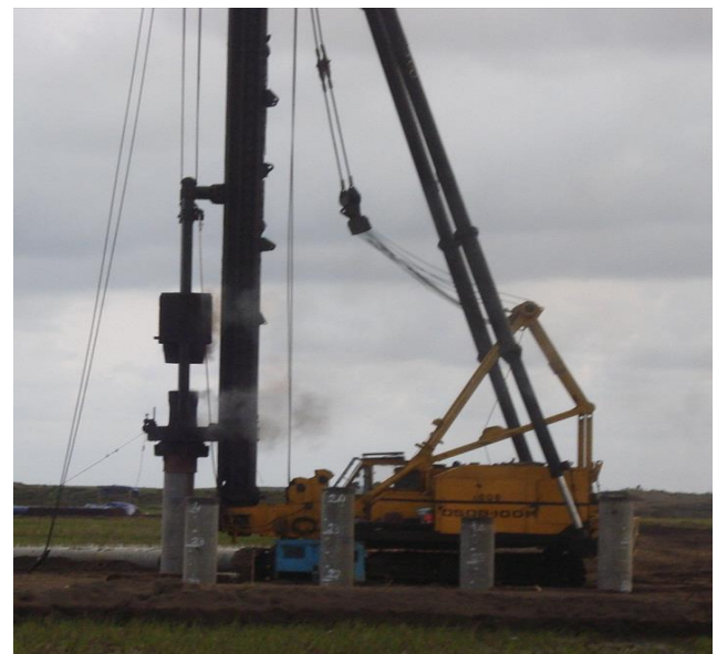
Hình 1.4. Thiết bị đóng cọc.
