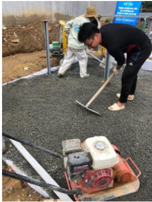
(c) Đổ bê tông xi măng rỗng cho lớp mặt
