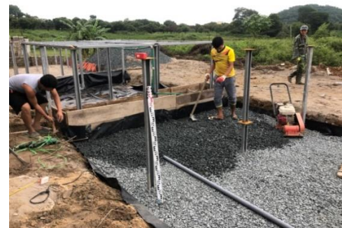
(a) Thi công lớp đáy móng
