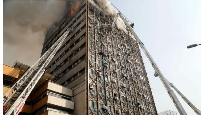
a) Tòa nhà đang bị cháy
