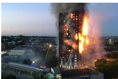
Hình 1. Công trình Grenfell Tower (Anh) bị cháy (nguồn:
