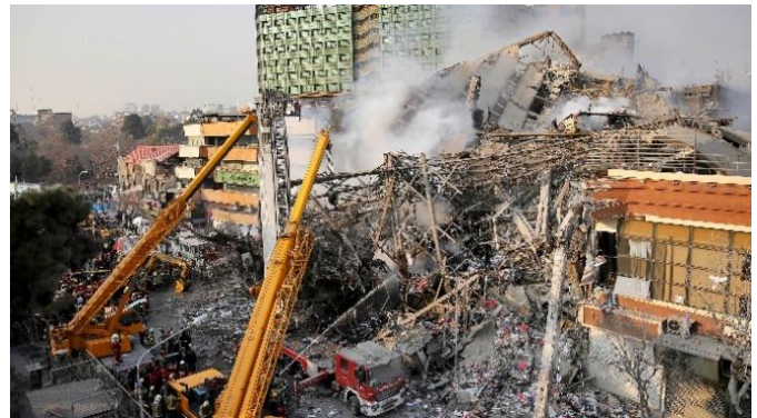
b) Tòa nhà đã bị sụp đổ do cháy
