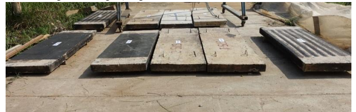
Hình 7. Các sàn BTCT chuẩn bị cho quá trình gia tải
