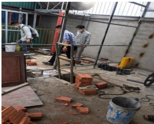
Hình 4. Hình ảnh mặt bằng trạm xử lý trước và sau cải tạo
