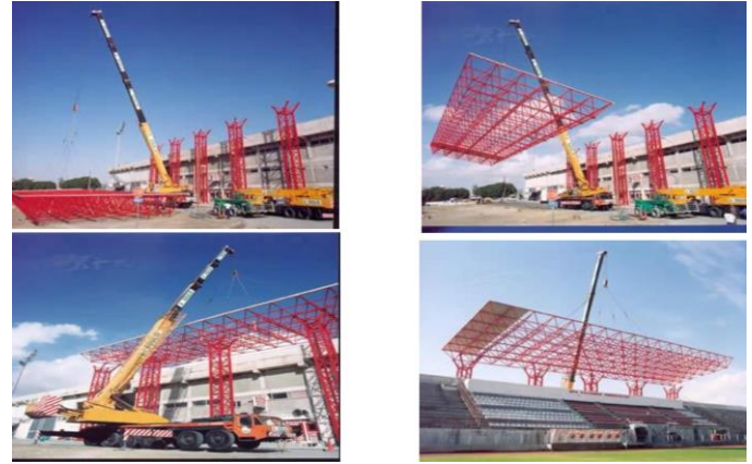
Hình 9. Một số công trình thực tế đã thi công theo phương pháp cầu lắp toàn khối.
