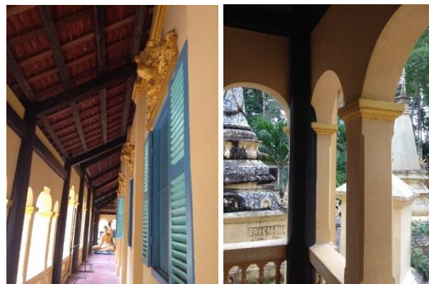
Hình 5. Kết cấu cột gỗ đỡ mái hiên.
