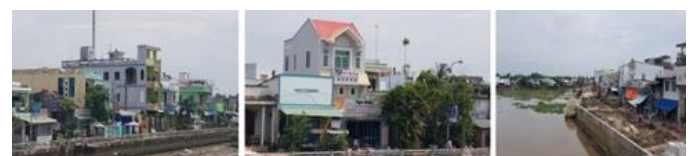
Hình 1. Hiện trạng nhà ở lô phố.
