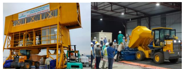
Hình 20. Trạm trộn tại hiện trường, xe xúc lật vận chuyển hỗn hợp UHPC.
