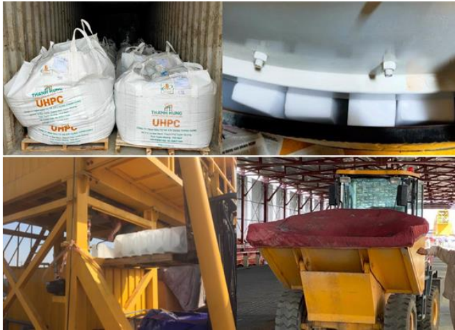
Hình 17. Hỗn hợp bột UHPC, đá khô CO 2 , đá cây công nghiệp và bạt phủ xe xúc lật.
