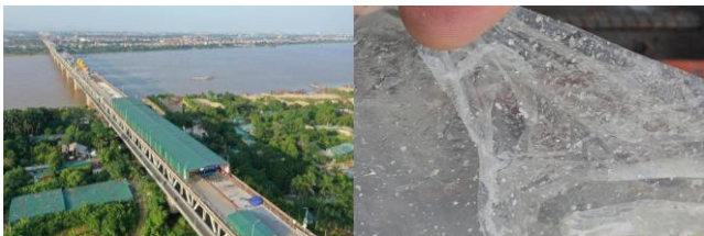
Hình 18. Nhà có mái che kín và màng fiml PVC có sẵn các hạt Silicagen.
