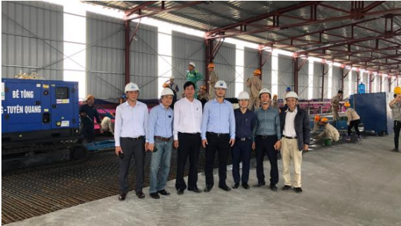
Hình 33. Đoàn công tác lãnh đạo Hội Bê tông Việt Nam thị sát hiện trường thi công sửa chữa mặt cầu Thăng Long.
