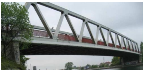
Hình 7. Cầu Illzach tại Pháp được sửa chữa năm 2009.
