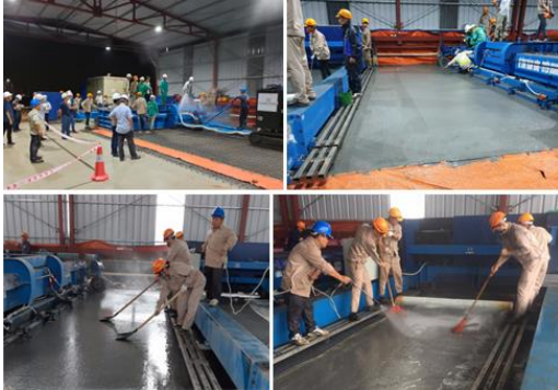
Hình 21. Máy rải – đầm – cán và sàn thao tác tại hiện trường thi công.
