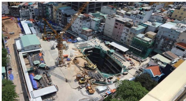
Hình 7. Thực tế thi công ở giai đoạn thi công kết cấu móng – sàn B5.
