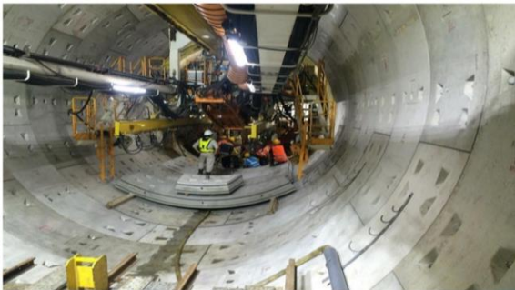
Hình 9. Hình ảnh thi công thực tế tuyến Tunnel.
