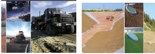
Hình 5. Các dạng kết hợp Neo - Web với vật liệu khác làm đường và bảo vệ sườn dốc.
