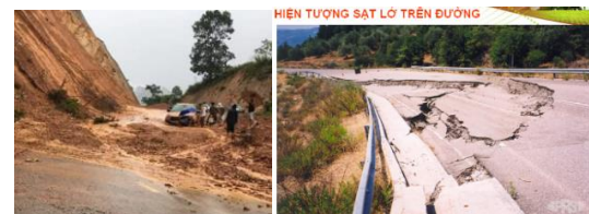
Hình 1. Hình ảnh sườn dốc, mái ta luy mất ổn định.
