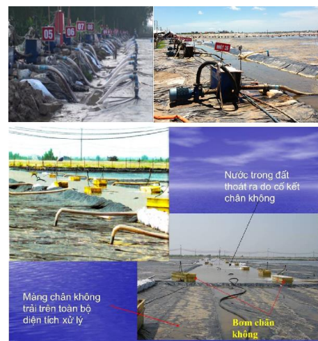
Hình 5. Một công trình cải tạo đất bằng phương pháp bấc thấm kết hợp hút chân không.
