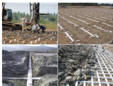
Hình 4. Thi công bấc thấm.
