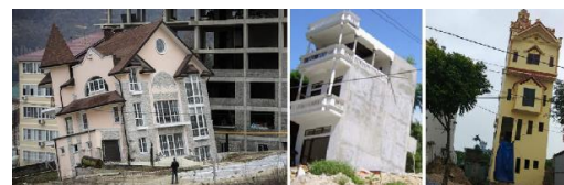
Hình 1. Hậu quả khi xây dựng công trình trên nền đất yếu.
