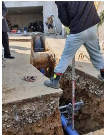
Kiểm tra Giếng thăm sau khi đầu nối với cống bên ngoài Lắp đặt đường cống đầu nối với thiết bị thải nước
