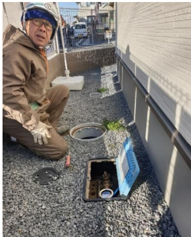
Kiểm tra Giếng thăm sau khi đầu nối với cống bên ngoài Lắp đặt đường cống đầu nối với thiết bị thải nước
