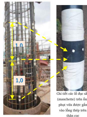
Hình 2. Chi tiết ống phụt vữa thân cọc được gắn vào lồng thép trên thân cọc [27].
