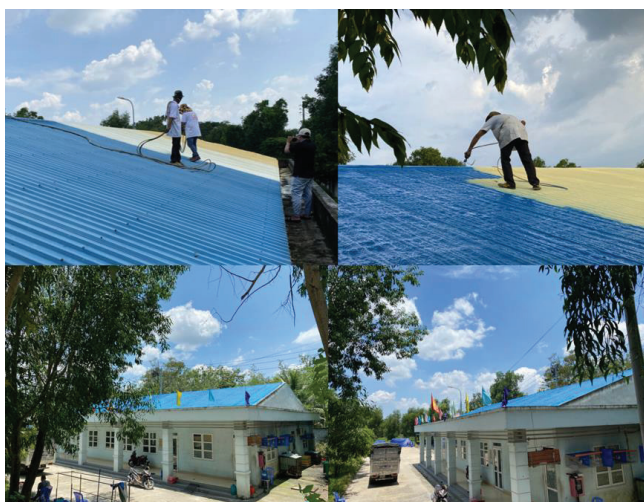
Hình 9. Hình ảnh thi công phun xốp cách nhiệt.
