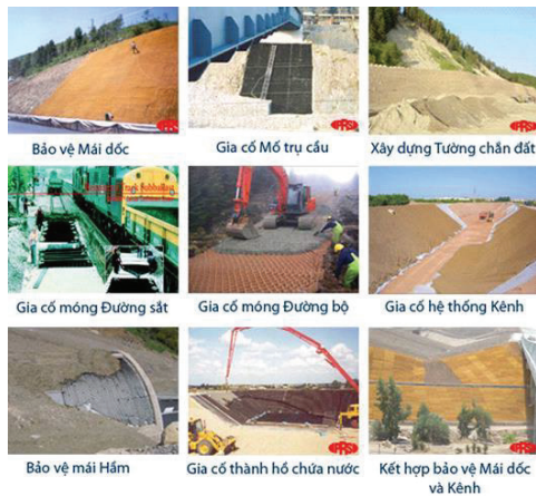
Hình 2. Áp dụng giải pháp Neoweb.
