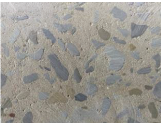
Hình 4. Làm nhẵn bề mặt dầm.
