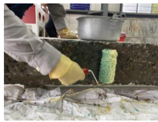
Hình 5. Phủ keo lót lên bề mặt đã làm nhẵn.
