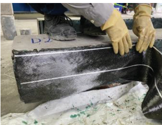
Hình 6. Dán tấm carbon lên bề mặt đã phủ keo.
