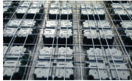
(d) Sàn lồi rỗng bằng hộp nhựa (Uboot)
