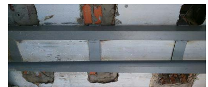
(b) Hình ảnh thi công thực tế
