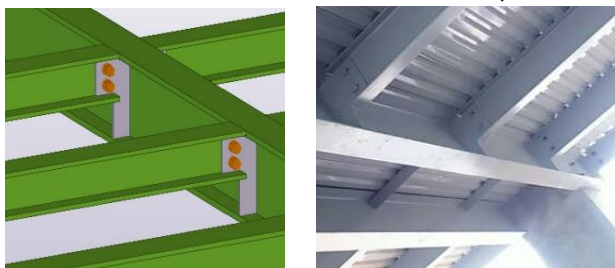
(a) Vẽ mô hình (b) Hình ảnh thi công thực tế
