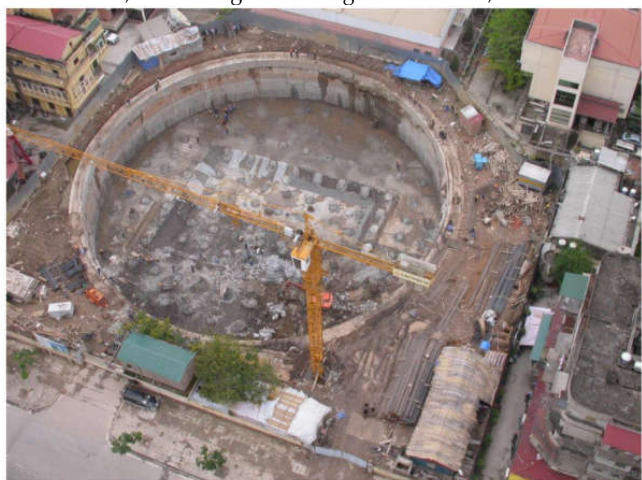
Hình 2.2 – Hố đào hình tròn dự án VNPT Tower
