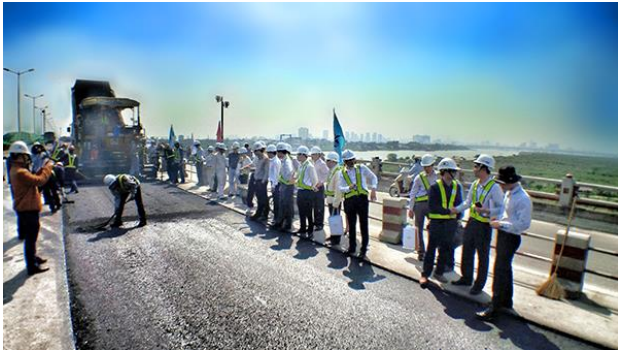
Hình 3. Nhựa đường cao su thi công thử nghiệm ở cầu Thanh Trì [7].
