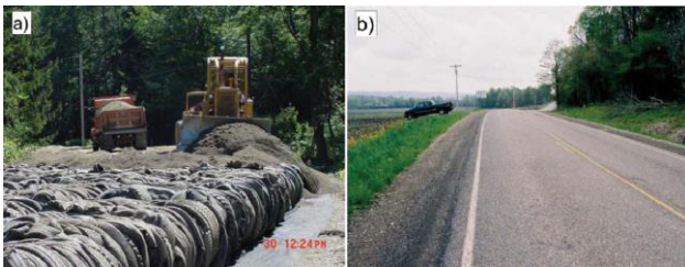
Hình 13. Nền đường đóng kiện lớp ở Hạt Chautauqua, Hoa Kỳ: a) đặt lớp sỏi lên các kiện lớp; b) con đường đã hoàn thành [14].
