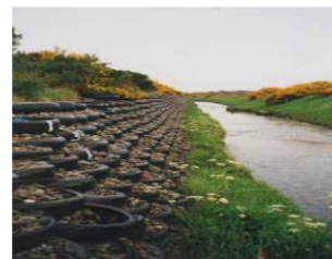
Hình 15. Gia cố chống sạt lở mái ta luy bờ kênh [13].
