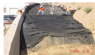
Hình 10. Pha trộn lớp xe phế thải với cốt liệu khác để đắp đất thành tường chắn [13].
