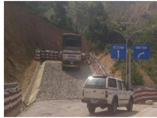
Hình 8. Tường hộ lan của hố cứu hộ cứu nạn làm bằng lớp xe phế thải trên Đèo Lò Xo thuộc đường Hồ Chí Minh (Quảng Nam) [12].
