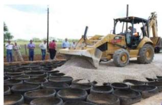
Hình 5. Dùng lốp xe phế thải làm đường bê tông cơ khí [10].
