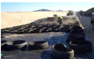
Hình 4. Dùng lốp xe phế thải làm đường bê tông cơ khí [9].
