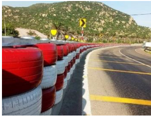
Hình 7. Sơn phản quang hoàn thiện tường phòng hộ khung thép xếp lớp xe cũ chống va đập trên QL1A thuộc tỉnh Bình Thuận.
