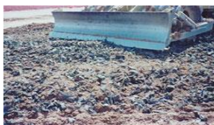
Hình 9. Pha trộn lớp xe phế thải với đá vụn làm lớp móng nền
