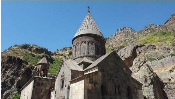
Hình 6. Tu viện Geghard (thế kỷ 13) với mái vòm hình nón - đặc điểm nổi bật của kiến trúc nhà thờ Armenia thời trung cổ (Nguồn: https://en.wikipedia.org )
