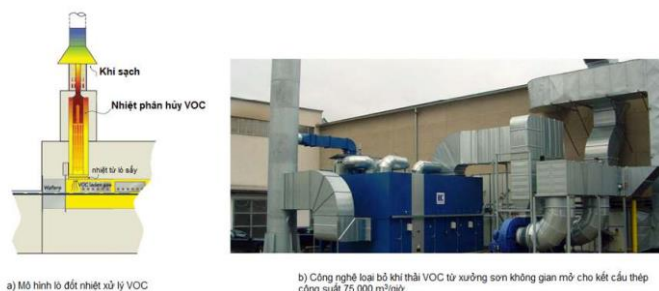
Hình 8. Công nghệ lò đốt nhiệt xử lý VOC.
