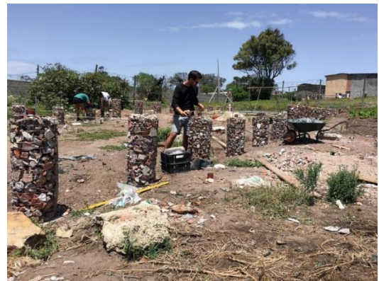
Hình 5. Sử dụng bê tông gạch vỡ để tạo cột chịu lực (Nguồn: Lim’uphile Co-op, Nam Phi).
