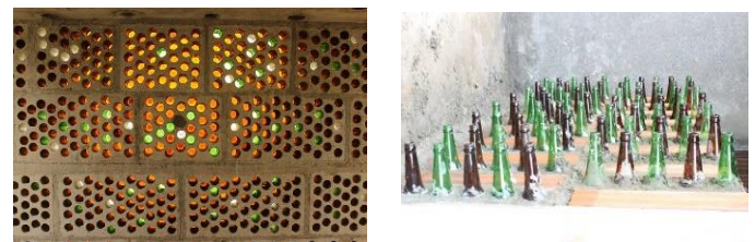
Hình 2. Sử dụng vật liệu tái chế để tạo độ rỗng cho lớp tường (Nguồn: Mud Hands Architects).
