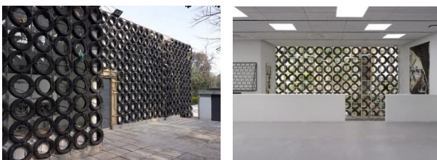
Hình 4. Sử dụng hệ lưới các vỏ bánh xe để tạo nên lớp thứ 2 của vỏ bao che (Nguồn: Tsibi Geva).
