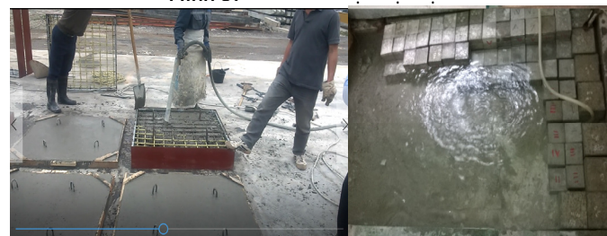
Hình 4. Hình ảnh đổ và bảo dưỡng bê tông.
