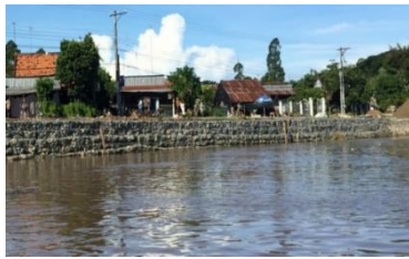
Hình 7. Gia cố bằng kè rọ đá.
