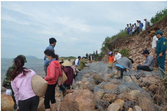
Hình 4. Giải pháp kỹ thuật sử dụng rọ đá, túi đá để gia cố đề biển bị vỡ khi mưa bão.
