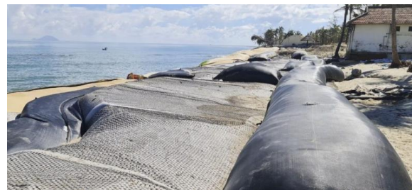
Hình 7. Giải pháp dùng ống vải địa kỹ thuật geotube.
