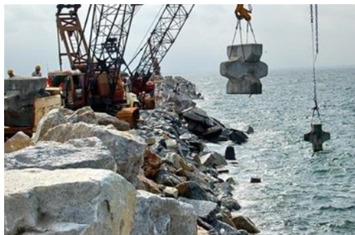
Hình 5. Cầu những khối đá lớn hoặc khối bê tông dị hình, xếp đặt, lèn chặt vào những chỗ đề biển bị sóng đánh vỡ.
