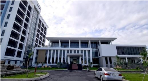
Hình 2. Trung tâm hành chính công và khối trụ sở các đơn vị sự nghiệp tỉnh Đồng Tháp.
