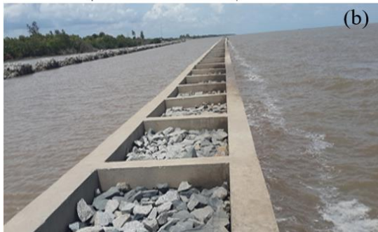
Hình 2. Kết cấu kè cọc ly tâm [19].
