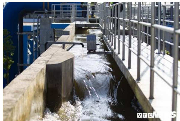
Hình 1. Bể nước sạch sông Đuống, có kết cấu bê tông cốt thép.
