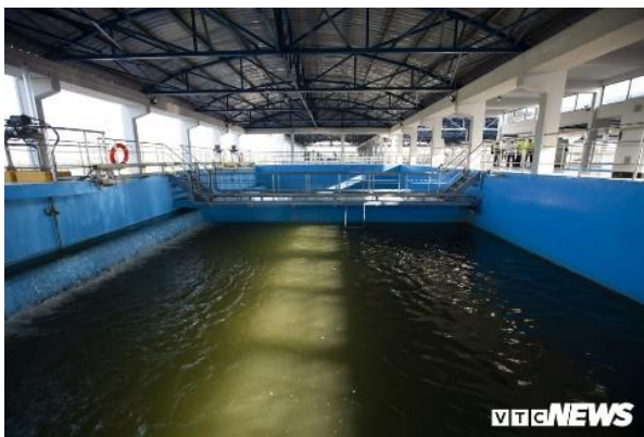
Hình 1. Bể nước sạch sông Đuống, có kết cấu bê tông cốt thép.
