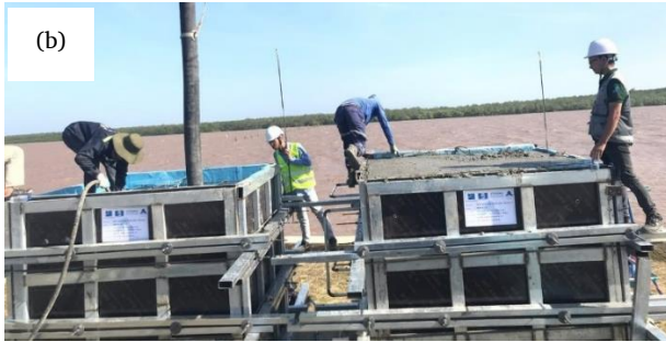
Hình 6. Hai khối đổ M0 và M1 (a) trước và (b) trong quá trình tạo hình.
