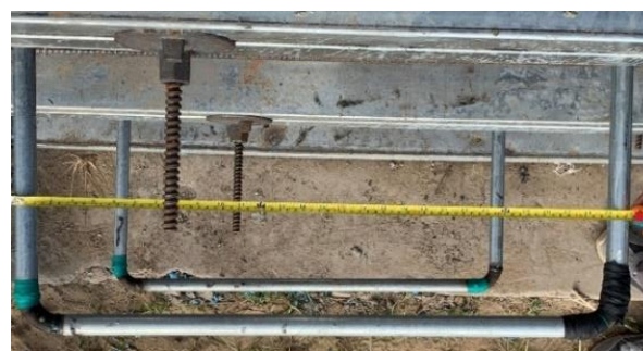
Hình 2. Hệ thống ống giải nhiệt cho khối đổ M1 tại hiện trường [11].
