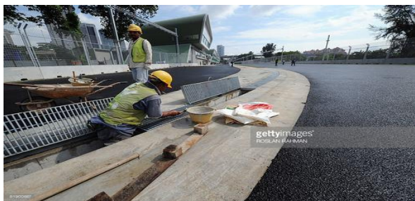
Hình 5. Một đường cống thoát nước đang được thi công tại đường phố Singapore.
