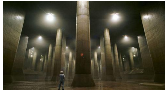
Hình 6. Hệ thống thoát nước ngầm khổng lồ.
